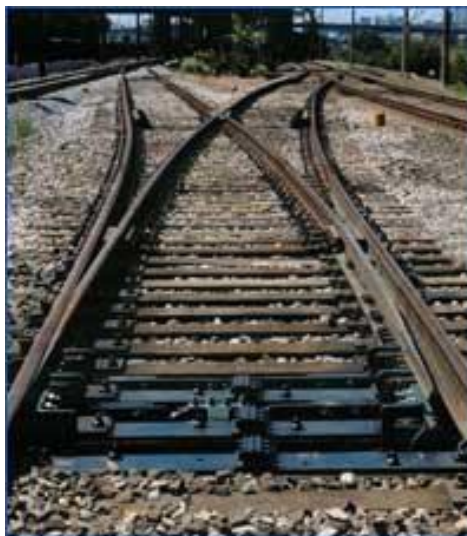
Figura 50 – Aparelho de mudança de via. Disponível em:
