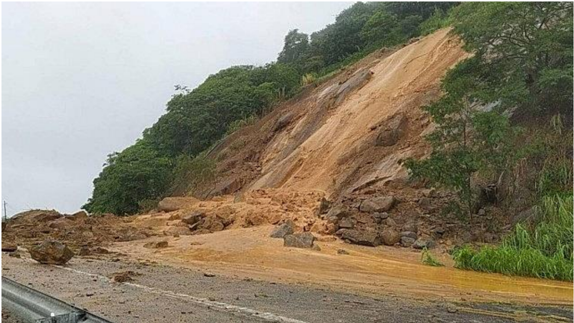
Figura 16 - Deslizamento de terra.
