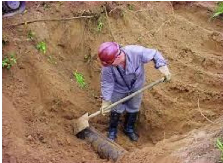
Figura 40 - Execução manual da terraplanagem.
