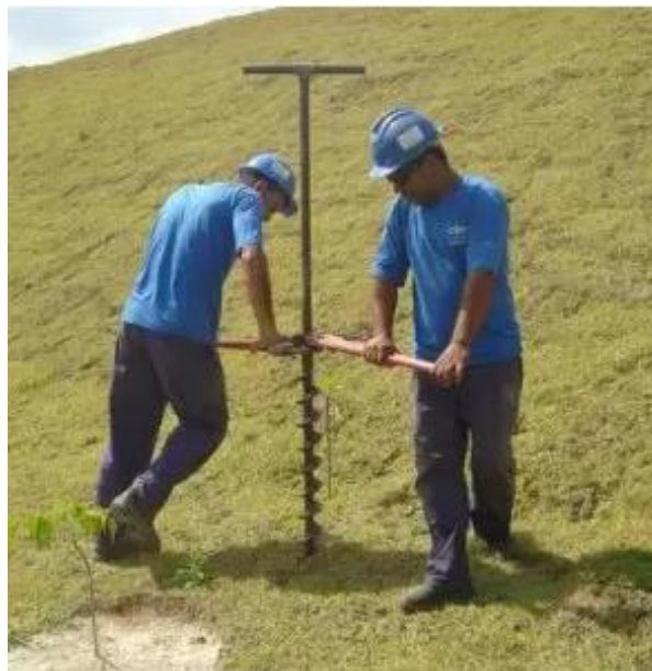
Figura 19 - Operadores realizando sondagem por meio de trado manual.
