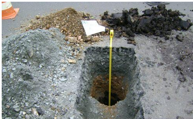
Figura 17 - Escavação de poço.
