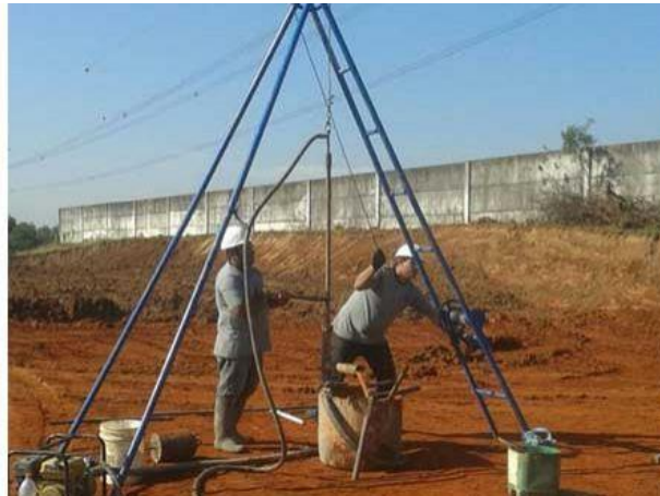
Figura 21 - Sondagem SPT.
