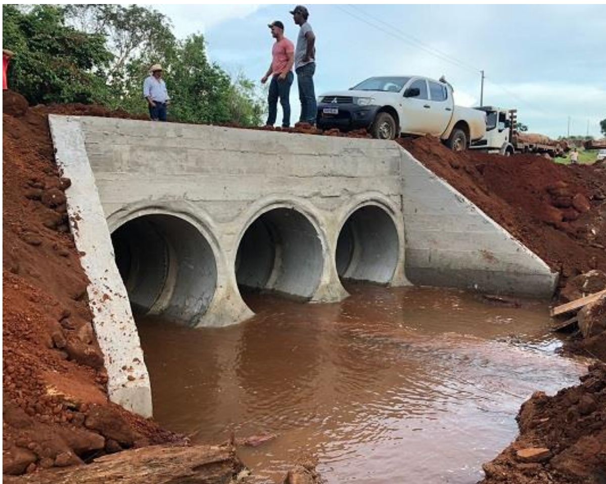
Figura 61: Bueiro com recobrimento insuficiente.
