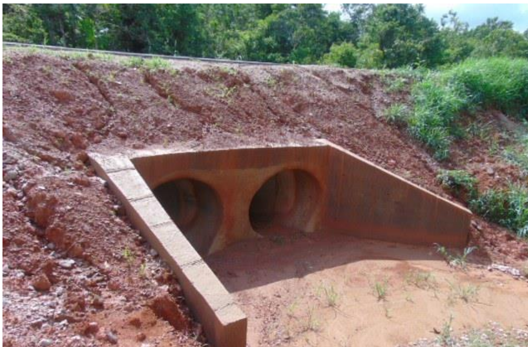
Figura 62: Bueiro com recobrimento necessário.
