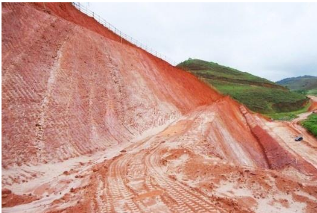
Figura 60: Corte alto.
