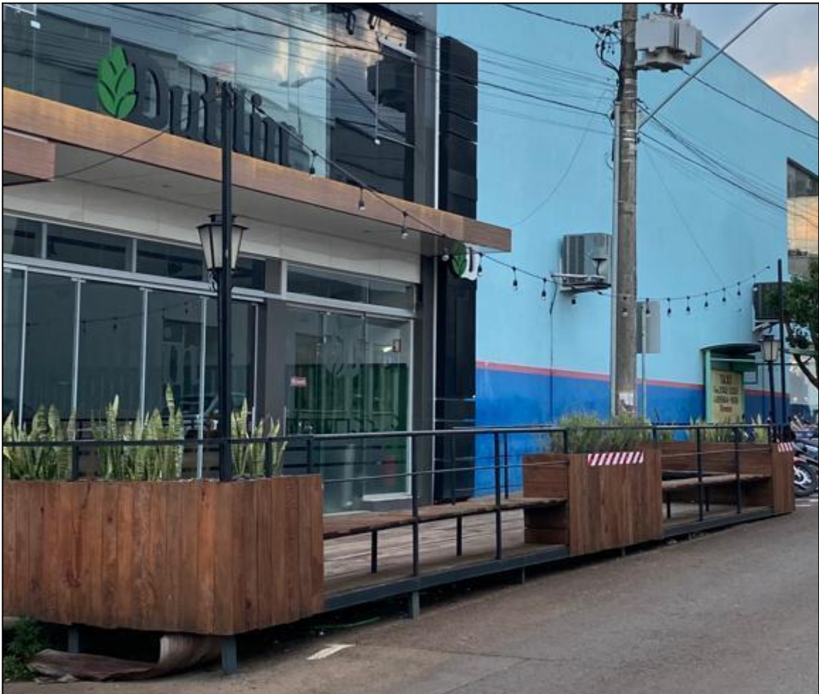
Figura 50: Parklet instalado na frente do estabelecimento Dublin, no centro de Palmeira das Missões.
