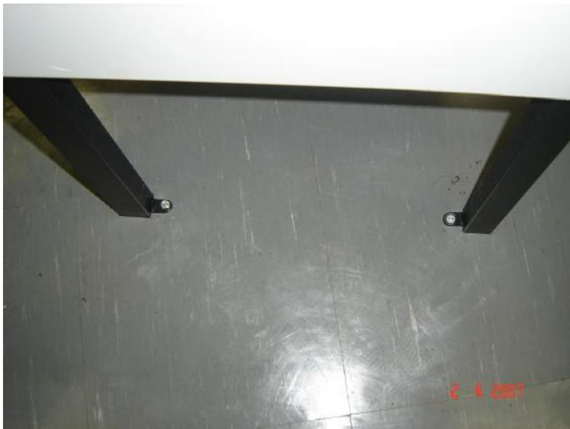
Foto1: Detalhe das pernas e sua fixação ao chão.
