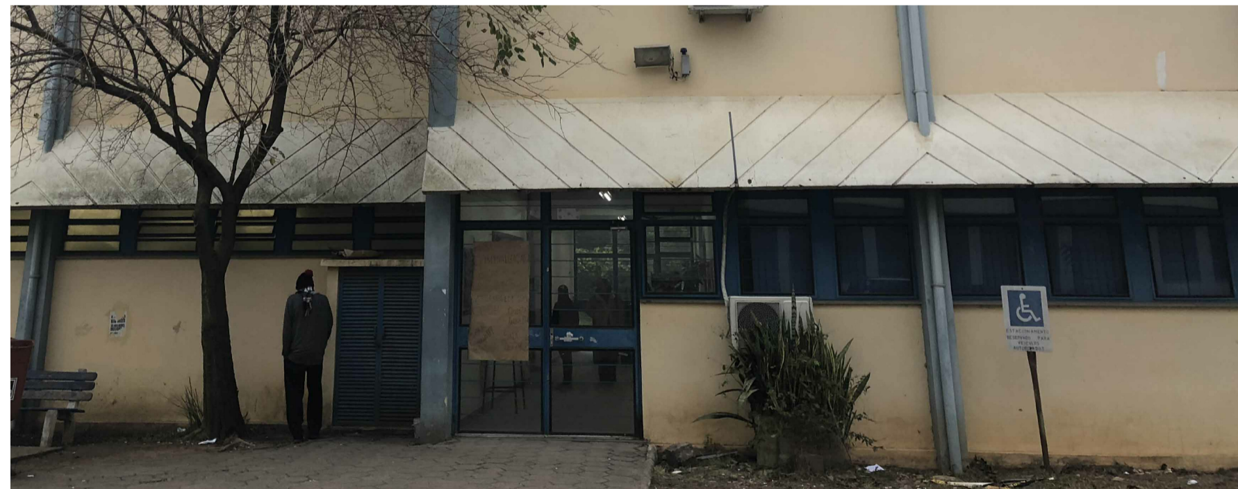
foto atual - parte de brise a demolir
