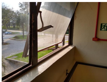
Figura 1. Remoção esquadria para instalação de saída de emergência (foto lado esquerdo) e enclausuramento da escada (foto lado direito)
