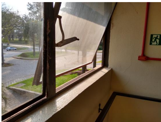
Figura 13. Modelo de vão que deverá ser enclausurado com alvenaria e instalação de nova janela, após abertura de novo vão
