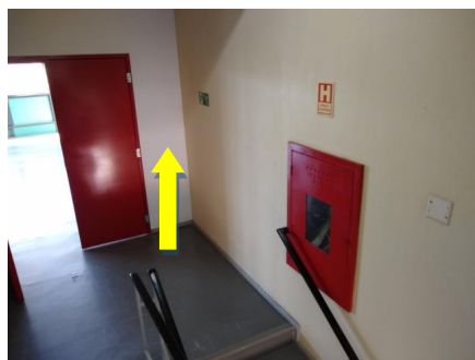
Figura 05 – Parede em “gesso branco” substituir por “gesso rosa” resistente ao fogo – 4 placas
