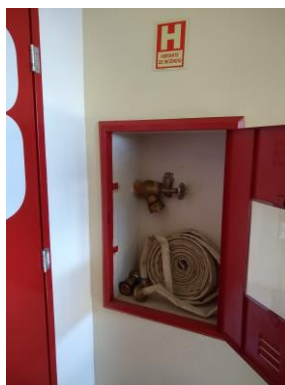
Figura 3. Remoção da caixa de hidrante e dos acessórios dos pontos situados dentro da caixa de escada
