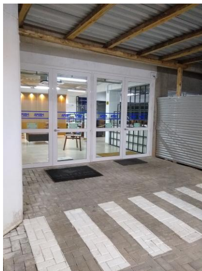
Figura 9. Modelo porta caixilhos em alumínio e vidro temperado para saída de emergência. Deverá receber barramento antipânico.
