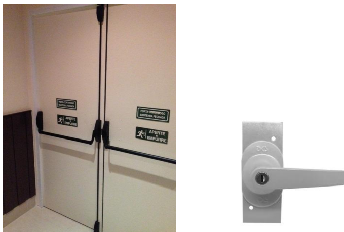
Figura 11. barramento antipânico tipo "push" e fechadura de sobrepor.
