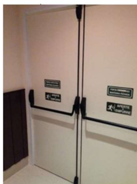
Figura 5: barramento antipânico tipo “push” e fechadura de sobrepor.
