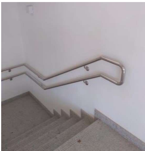
Figura 2: Modelo de corrimão em aço inox escada enclausurada - fixado na parede (C-03)
