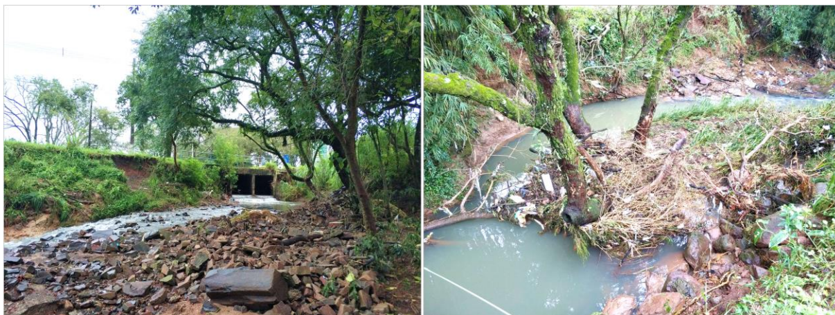
Figura 3. Ponto 3.1 com presença de materiais inertes que causam turbulência e obstrução do canal (à esquerda). Ponto 4.1 com banco de sedimentos na margem direita que causa estreitamento do canal e direcionamento do fluxo para a margem esquerda (à direita). Fotografias: Rita SOUSA, 2024.
