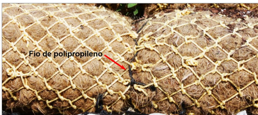
Figura 6. Detalhe da união entre biorretentores de coco adjacentes por meio de fio de polipropileno de 4 mm (centro da imagem). Fonte: Rita SOUSA, 2018.
