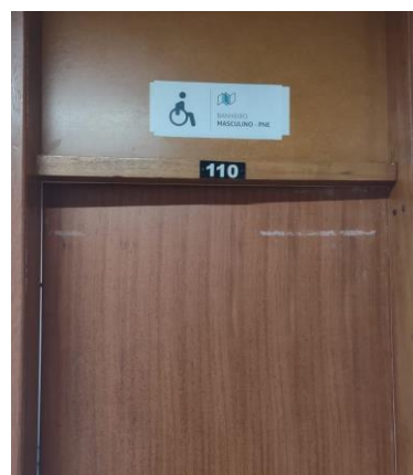
Figura 16 - Banheiro Masculino Acessível
