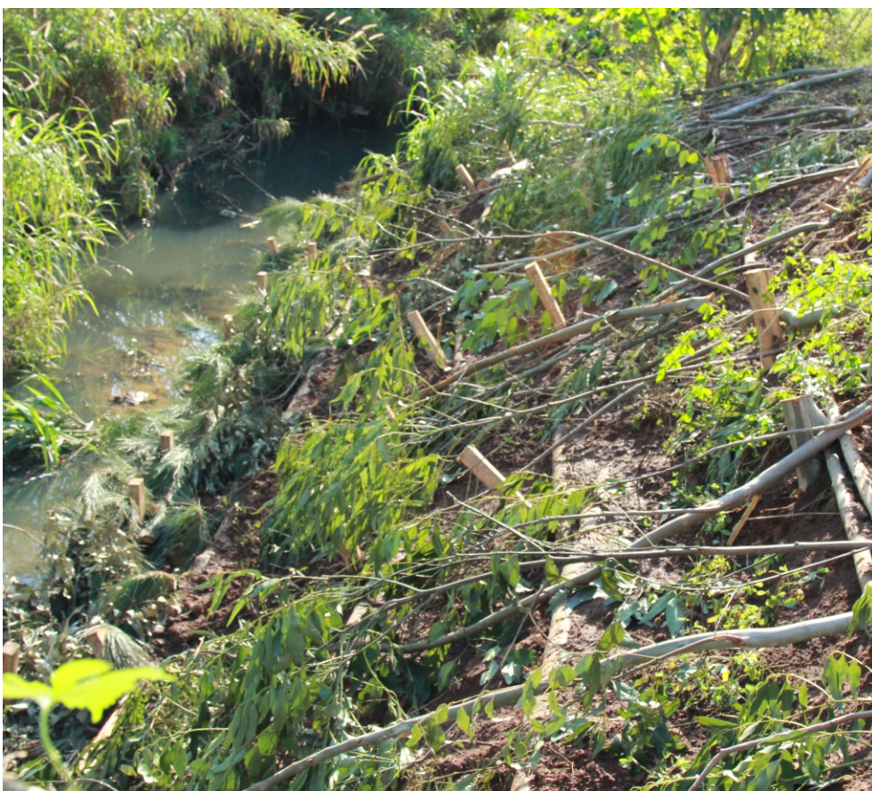
#Bioengenharia Estrutura natural foi montada em ribanceira do arroio que separa o CTISM do Ipê Amarelo com o objetivo de evitar a erosão a partir do desenvolvimento de raízes de plantas. A professora Denise Ester Ceconi, do Centro de Tecnologia, orientou o trabalho, que contou com uma acadêmica e funcionários da Sulclean. As raízes devem crescer em cerca de dois meses, diz Denise.
