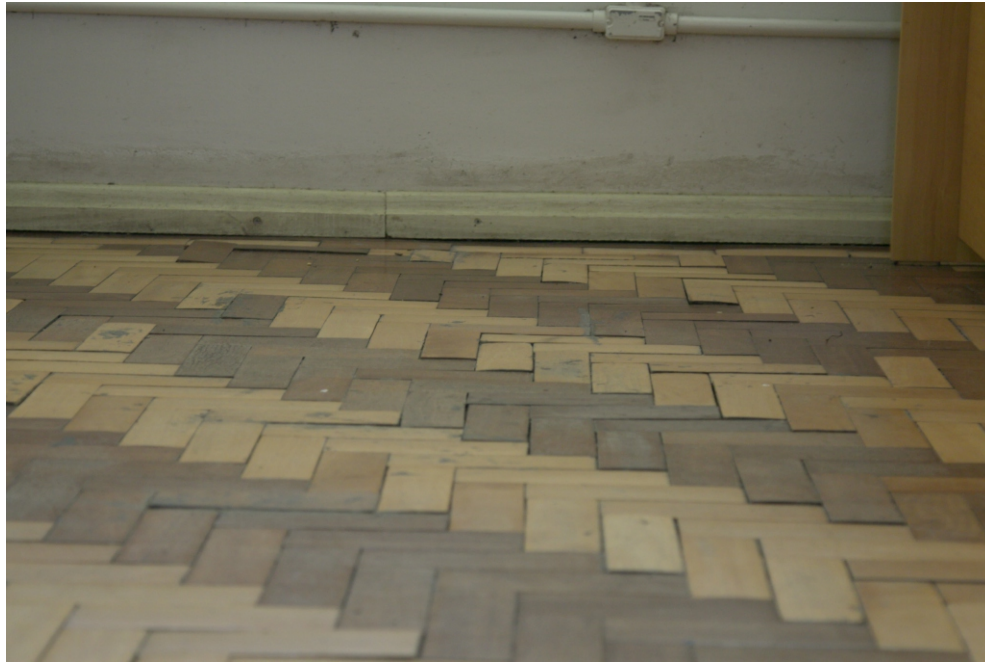
Piso de parquet se soltando dentro de sala de aula.
