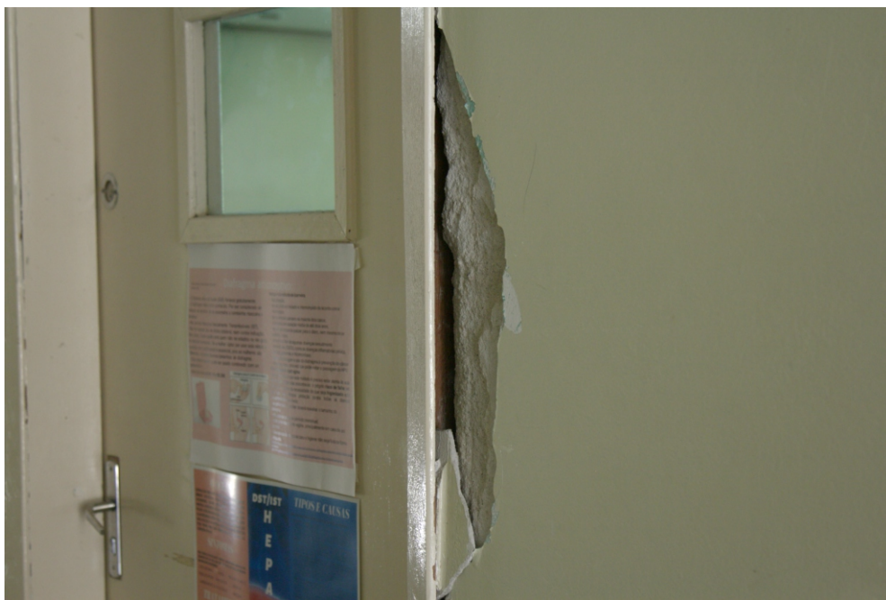
Rachadura na parede de sala de aula.
