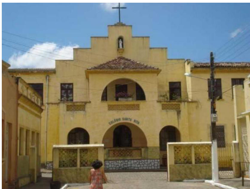
FIGURA 1 - Entrada principal do Colégio Santa Rita, em Areia. Fonte: Acervo de fotos do site do Colégio Santa Rita. Acesso em 11 de abril de 2012.
