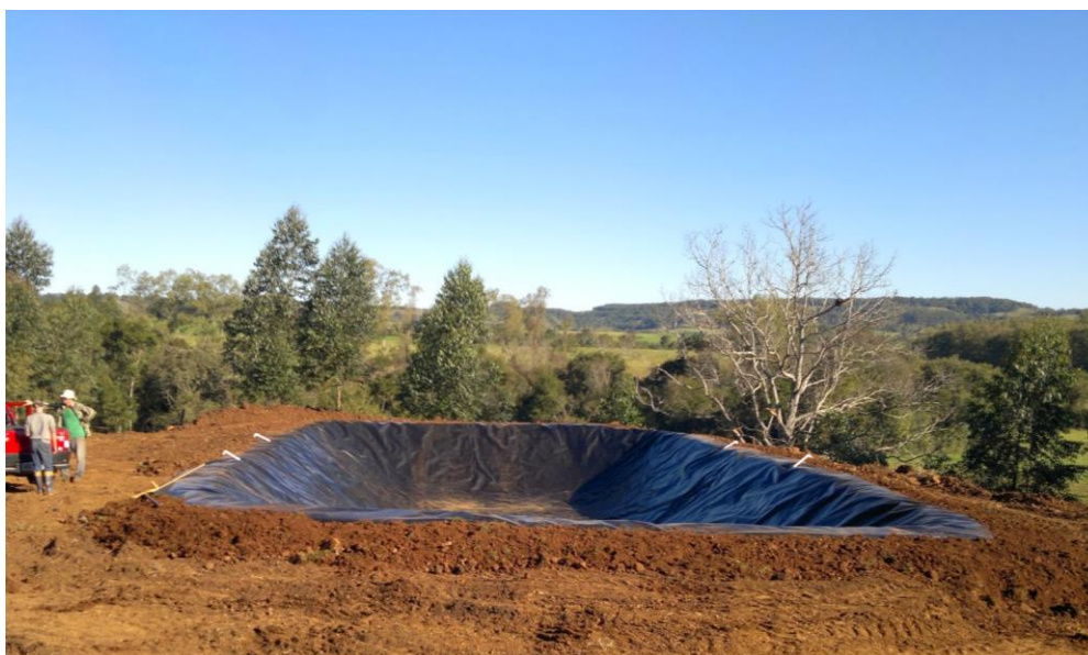
Figura 1 - Lagoa de estabilização recém instalada e pronta para receber o dejetos
