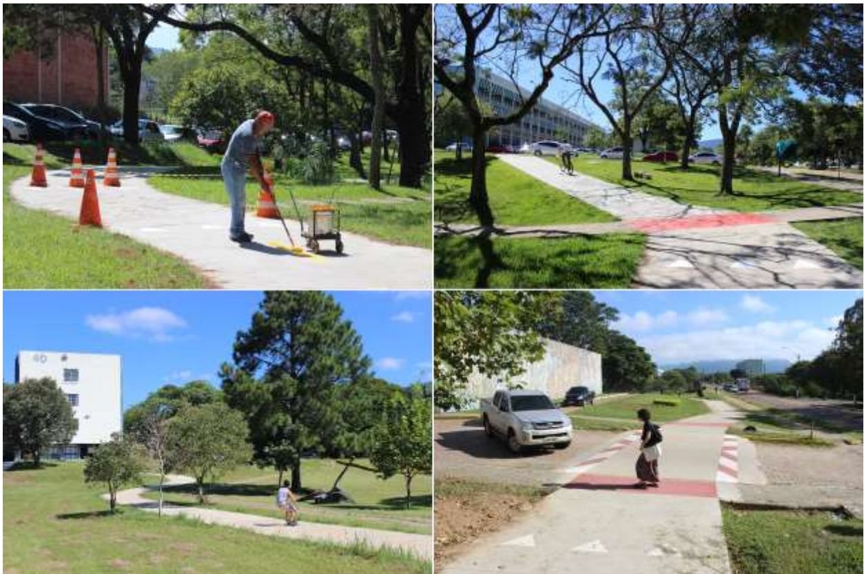
FIGURA 5 – Cenas da construção e utilização da Pista Multiuso no campus. Fonte: Arquivo Pessoal (2015).
