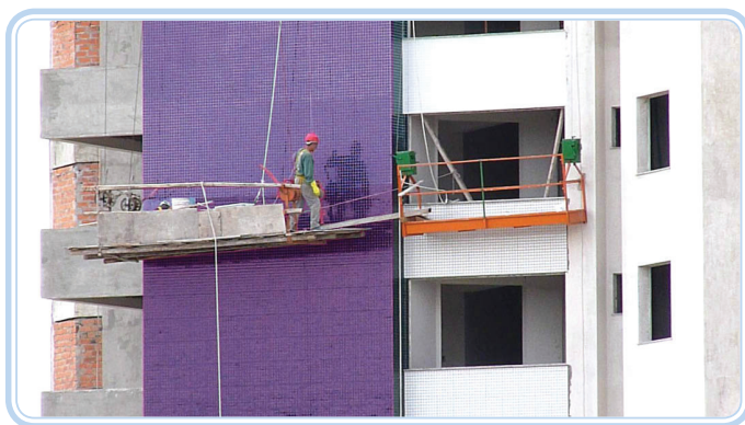
Figura 2.5: Condição insegura em andaime na construção civil
