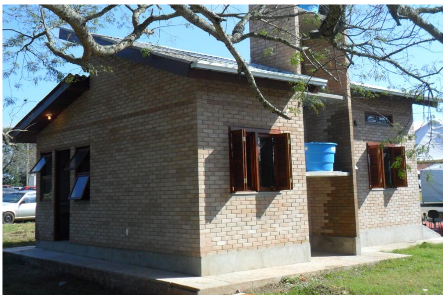
Figura 1 - Casa Popular Eficiente, construída no campus da UFSM Santa Maria/RS Fonte: VAGHETTI, M.A.O. et al., 2013
