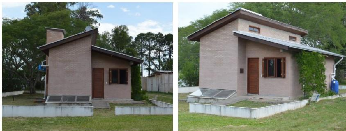
Figura 01: Casa Popular Eficiente, Centro de Eventos, Universidade Federal de Santa Maria.
