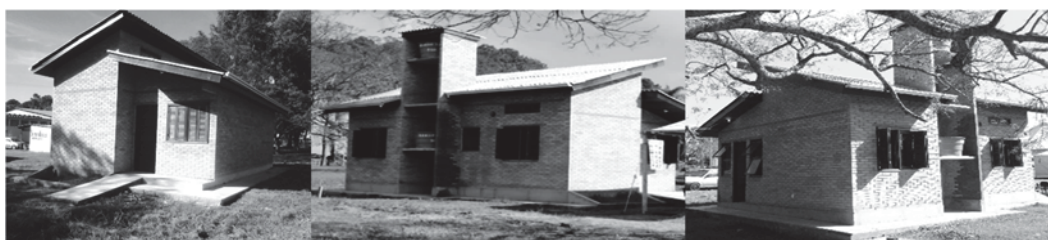
Figura 1. Fotos da “casa popular eficiente” (frente, lateral e fundos), localizada no parque do centro de eventos da UFSM
