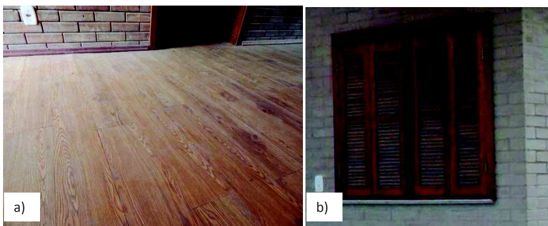
Figura 4: a) Piso de PVC reciclado; b) Esquadrias de Madeira.
