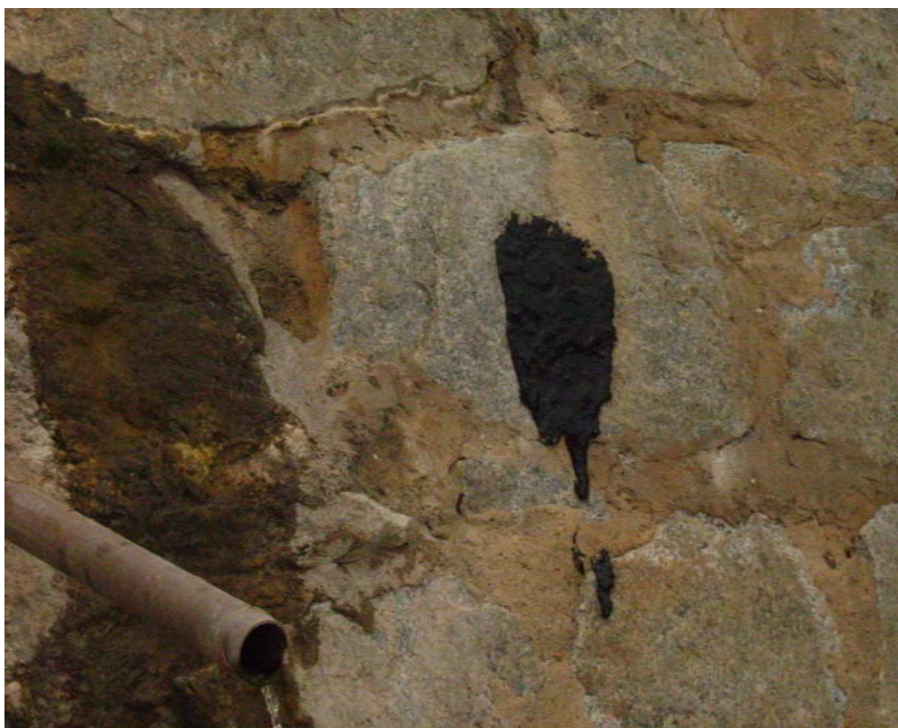
Foto 5 – Piche na parede de uma residência. Foto do autores.
