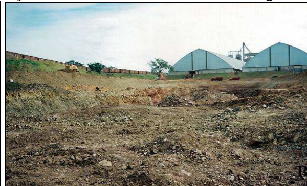
Figura 4.4.3. (A, B e C) Extração de rochas e sedimentos para a construção do Canal de atracamento; em (C) começa a surgência e o abarrotamento de água, o segundo ocasionado pela interligação com o Rio Paraná. Fonte: LABGEO – UFMS/CPTL, Março de 2007.
