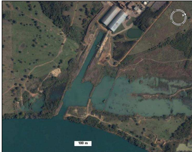
Figura 4.4.1. Imagem de Satélite situando o Canal de Atracamento Fluvial; inverno de 2004. Fonte: Google Earth, aquisição em Março de 2007.
