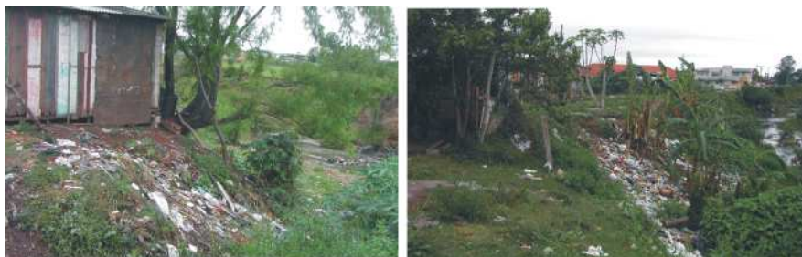
Figuras 4 e 5 – Moradia localizada em área de risco e lixo colocado nas margens do arroio. Autora– Springer, Kalina
