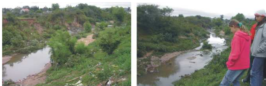
Figuras 8 e 9 – Degradação Ambiental: Erosão das margens e assoreamento do arroio Cadena Autora– Springer, Kalina
