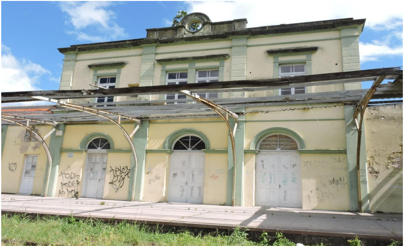
Figura 30: Estado atual (2019) do prédio principal da Estação Férrea de Santa Maria/RS, na sua fachada norte, área da gare. Autor: Marcelo Gabriel Ercolani – 2019 (UFSM/NEFERS).
