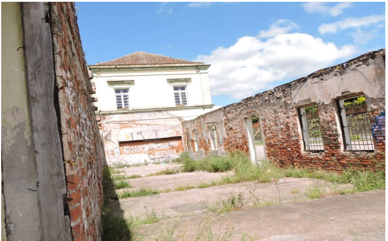
Figura 29: Estado atual (2019) do prédio lateral (antiga área do almoxarifado e da venda de passagens) da Estação Férrea de Santa Maria/RS. Autor: Marcelo Gabriel Ercolani – 2019 (UFSM/NEFERS).
