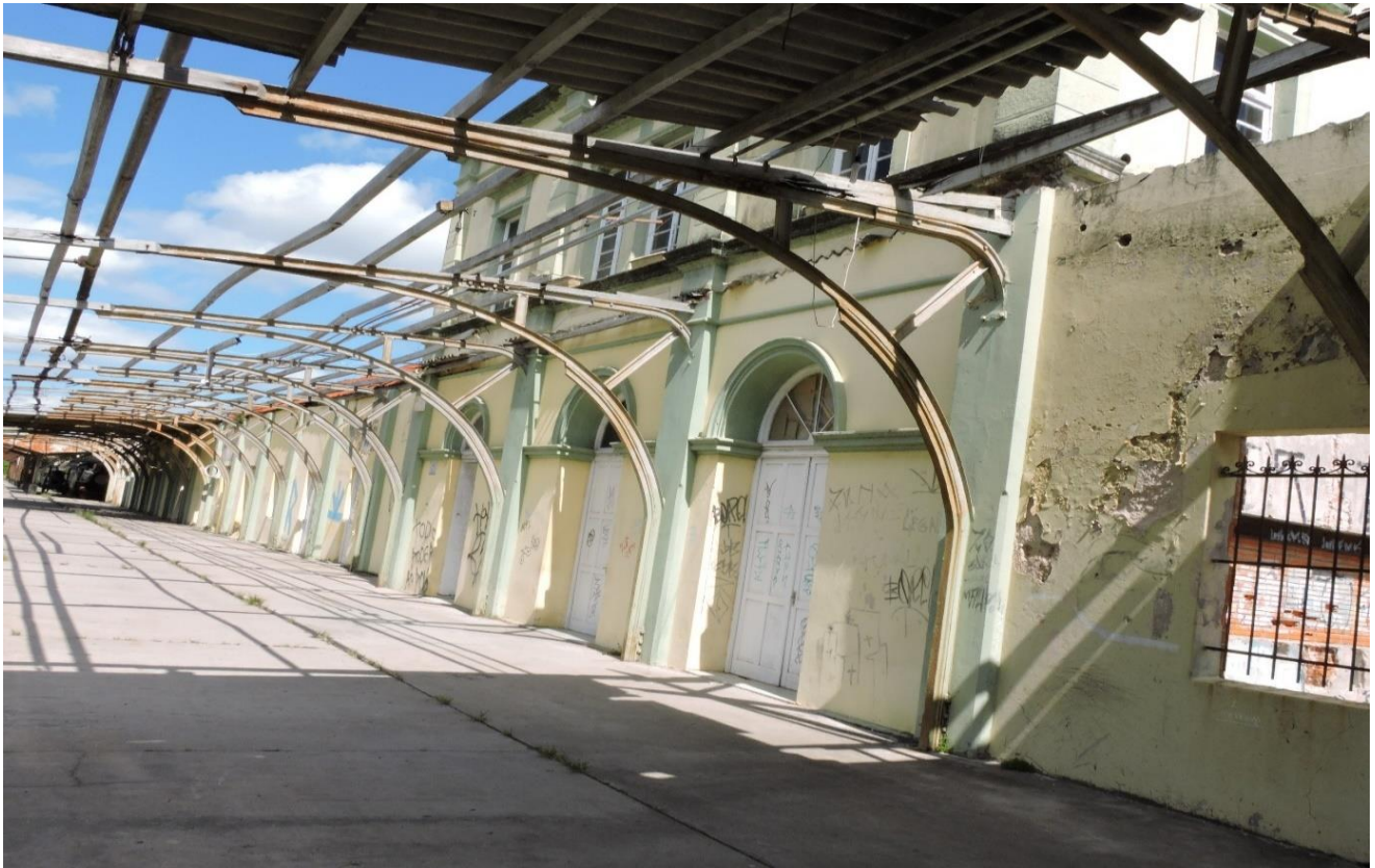
Figura 32: Estado atual (2019) do prédio principal da Estação Férrea de Santa Maria/RS, na sua fachada norte, área da gare. Visão diagonal, de oeste para leste. Autor: Marcelo Gabriel Ercolani – 2019 (UFSM/NEFERS).
