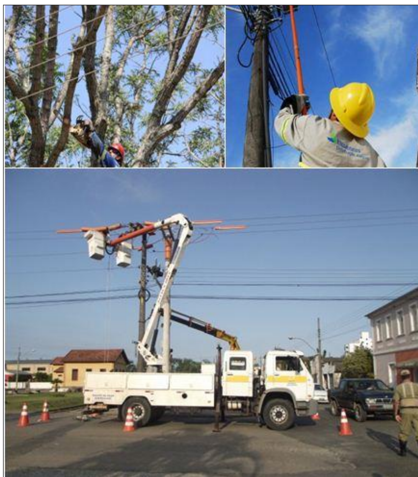
Figura 47 - Manutenção Preventiva das Redes de Distribuição de Energia Elétrica.
