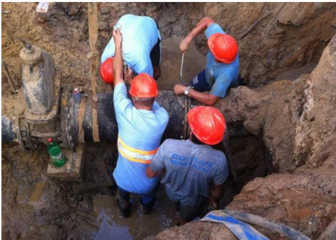
Figura 14 – Serviços de reparo em uma adutora de distribuição de água potável
