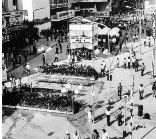
Figura 2 – Construção do Calçadão de Curitiba
