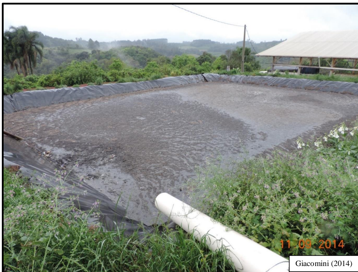
Figura 1. Esterqueira anaeróbica descoberta e revestida com geomembrana, para o armazenamento de dejetos líquidos de suínos.
