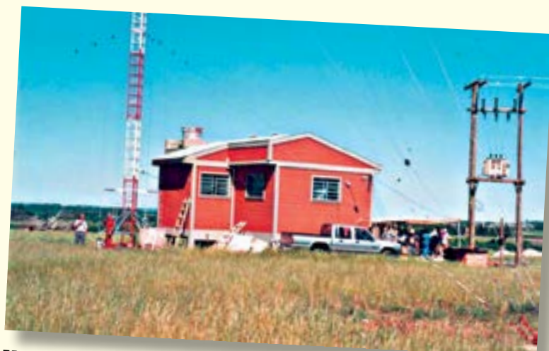
INAUGURAÇÃO DA CASA DE TRANSMISSÃO E NOVA TORRE - 1995
