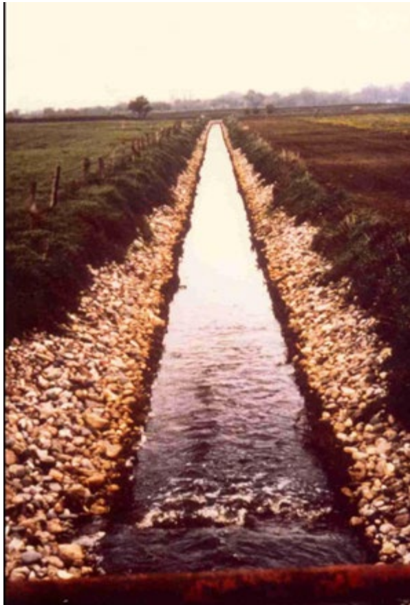
Figura 19- Canal retificado Fonte: Acervo W.W.
