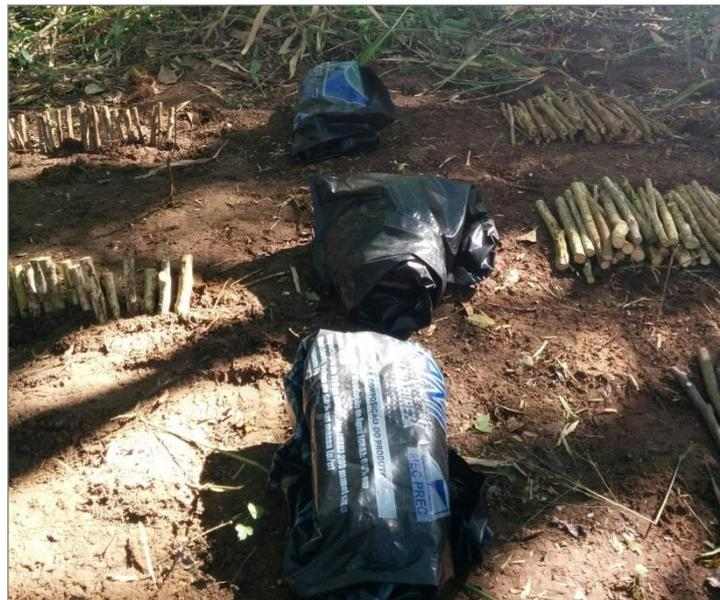
Figura 11. Estacas vivas parcialmente enterradas.
