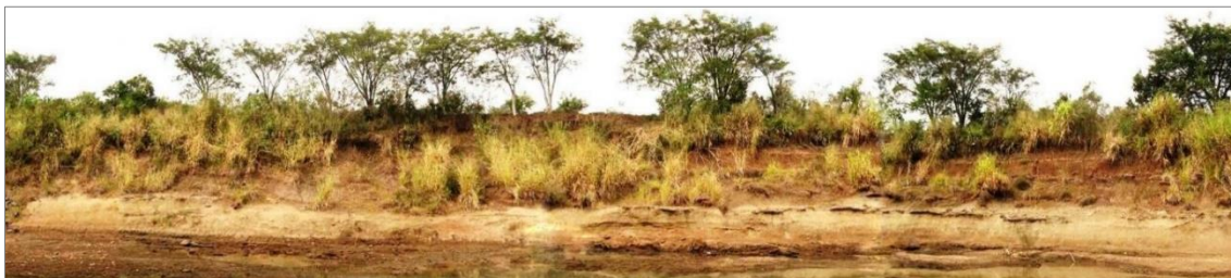
Figura 1 – Vista frontal do trecho antes da intervenção com talude com inclinação acentuada e presença de árvores de grande porte no topo. (Fotografia: Sutili, 2009). Figure 1 – Front view of the stretch before intervention with the slope with high gradient and presence of tall trees at the top. (Photography: Sutili, 2009).
