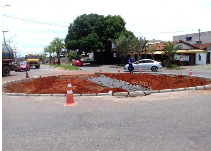
Figura 5 - Preparação de um jardim de chuva em Goiânia
