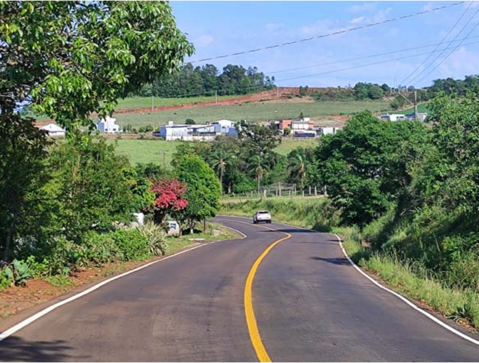
Estrada Santo Caeran após pavimentação. | Foto: Luiza Campos
