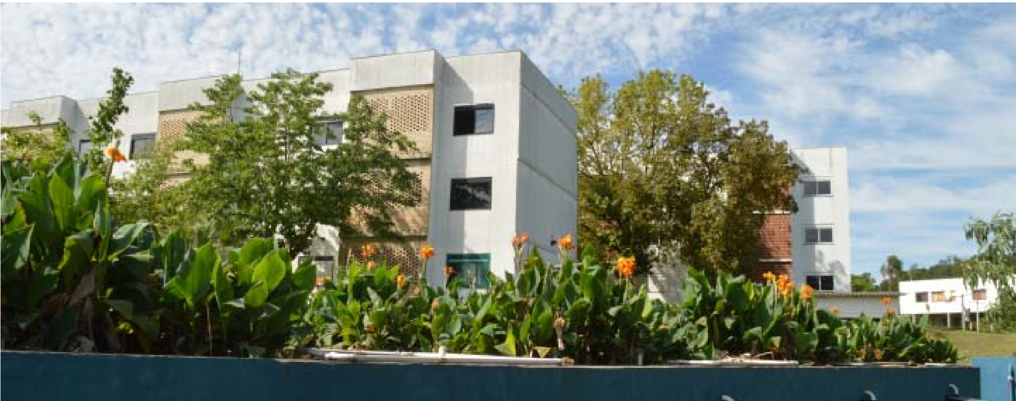
Sistema de Wetlands Construídos instalados no campus da UFSM/FW; ao fundo, a Casa do Estudante. Foto: Gabrielly Menezes
