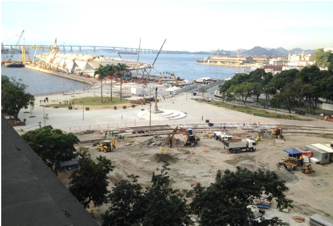
Figura 4 - Praça Mauá na zona portuária do Rio de Janeiro. Período das obras do projeto Porto Maravilha. Fonte: fotografia de Juliana Pavan, 28 de maio de 2015.
