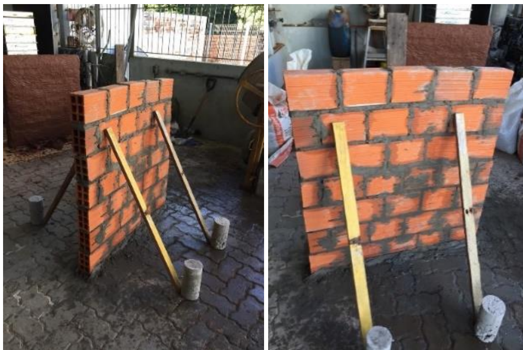
Figura 4 - Parede de tijolos seis furos finalizada com sete camadas, Conjunto II da Universidade Franciscana, Santa Maria – RS. Fonte: Acervo da acadêmica Taissa Kulmann Werlang.
