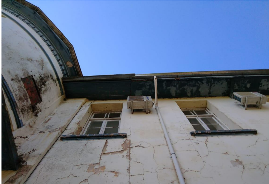
Figura 4 - Detalhe da fachada frontal da edificação construída em 1931. Fonte: Autores, 2019.
