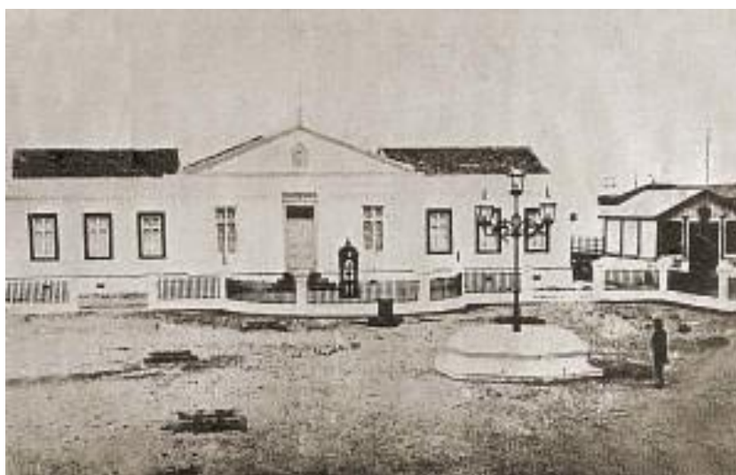
Figura 5 - Consulado Provincial de Alagoas, fachada original, Jaraguá – AL Fonte: Edberto Ticianeli Pinto, 2015
