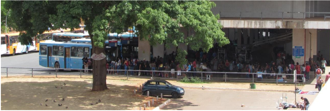
Figura 7 - Térreo do Edifício Touring utilizado como terminal de passageiros em Brasília-DF. Fonte: Fotografia de Rafael Martins, 26 de outubro de 2019.
