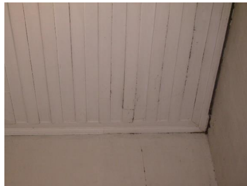
Forro em saia e camisa de cômodo da residência.
