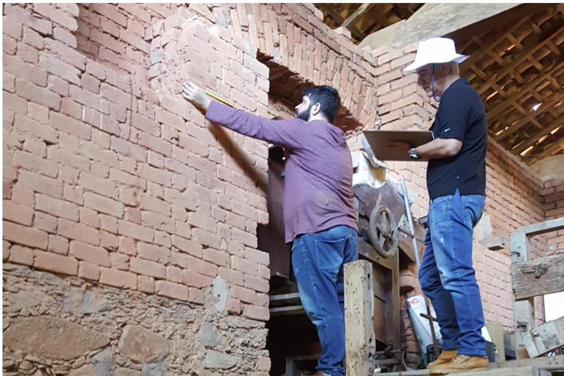
Figura 8 - Fazenda Espírito Santo do Atibaia, Tulha de Pedra, mensuração dos componentes construtivos da alvenaria oeste.
