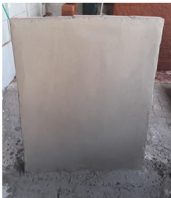
Figura 7 - Finalização do processo de reboco, Conjunto II da Universidade Franciscana, Santa Maria – RS. Fonte: Acervo da acadêmica Bruna de Cássia C. Gonçalves.
