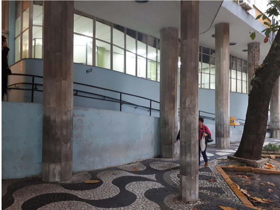
Figura 4 - Rampa do Edifício das Diretorias, centro de Florianópolis- SC. Fonte: fotografia de Anna Pimenta, 22 de julho de 2019.
