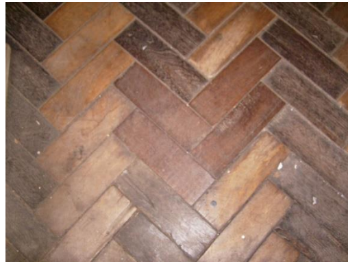
Detalhe de piso em tabuado de madeira da edificação.
