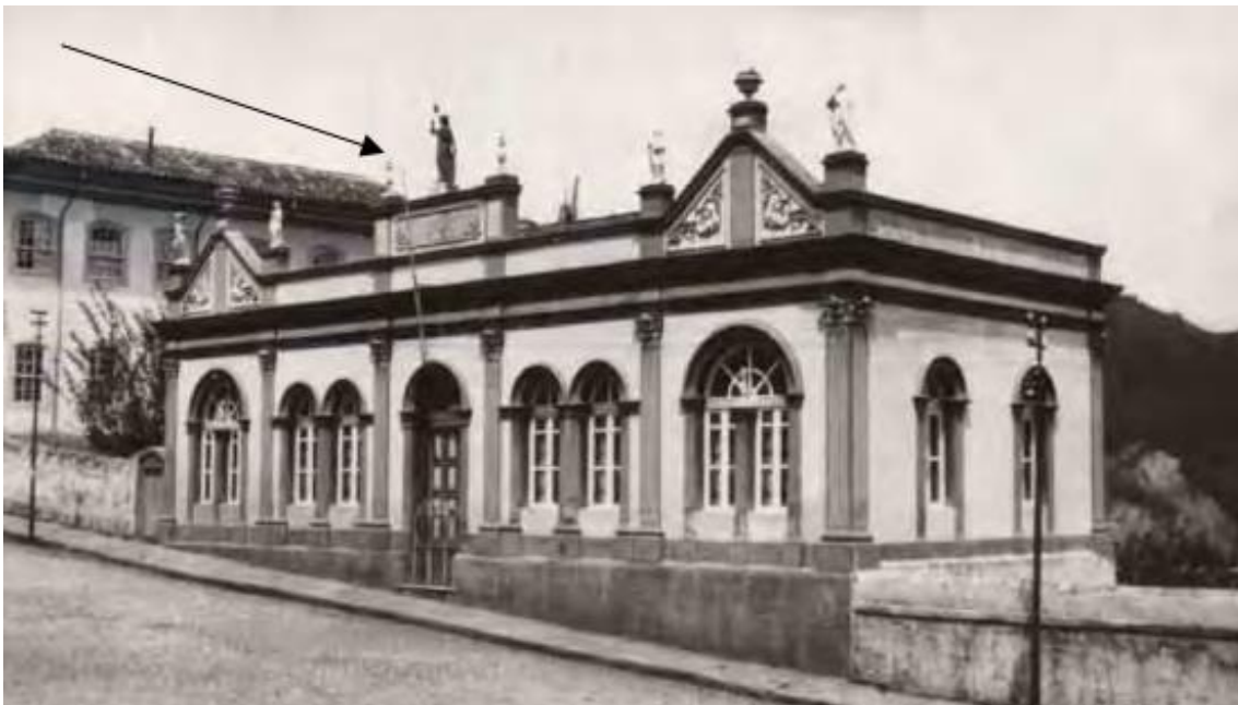
Figura 1 - Antigo Liceu de Artes e ofícios, antes da obra de restauro. Fonte: OLIVEIRA, 2006, p. 59.
