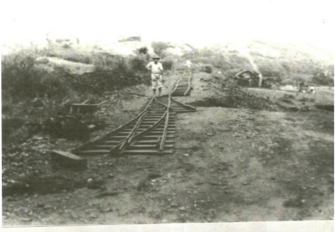
Figura 5 - Estruturação dos trilhos para as vagonetas manuais Fonte: Arquivo da CBC.
