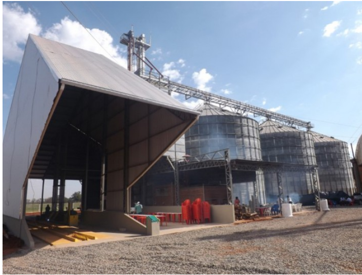
Figura 1 – Área coberta no local de descarga de grãos
