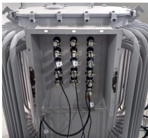
Figura 3.7 – Vista frontal com taps de alta tensão do TR001
