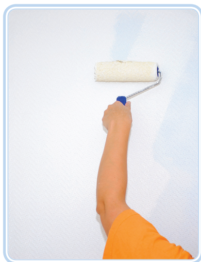
Figura 5.4: Impermeabilização de paredes
