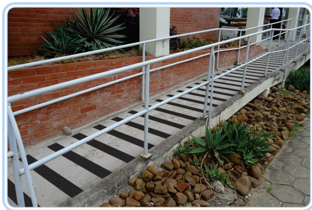
Figura 5.3: Rampas com fitas adesivas antiderrapantes
