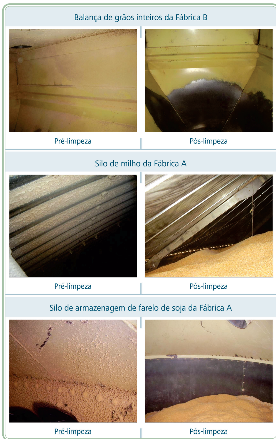
Figura 9.6: Pontos críticos de controle (pesagem e armazenagem de matérias-primas). Imagens antes e após limpeza de alguns equipamentos em duas fábricas de rações Fonte: Autores
